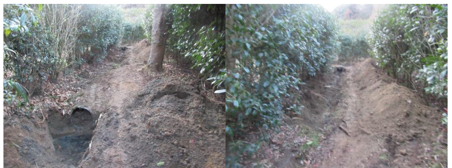
掘削した川下
