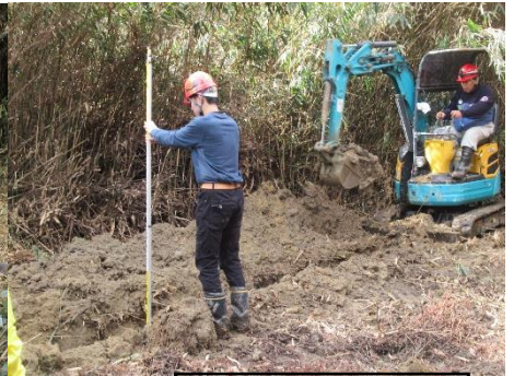
ユンボでの掘削
