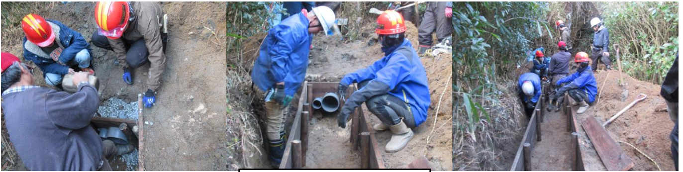
水路の側壁完成
