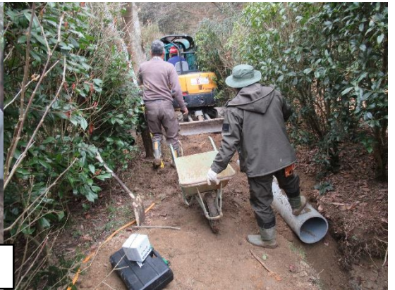
水路の地固めとパイプ埋設
