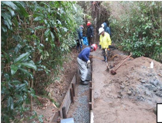
水路の地固めとパイプ埋設
